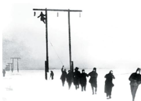
Рис. 3 Подвеска проводов при строительстве ледовой ЛЭП
